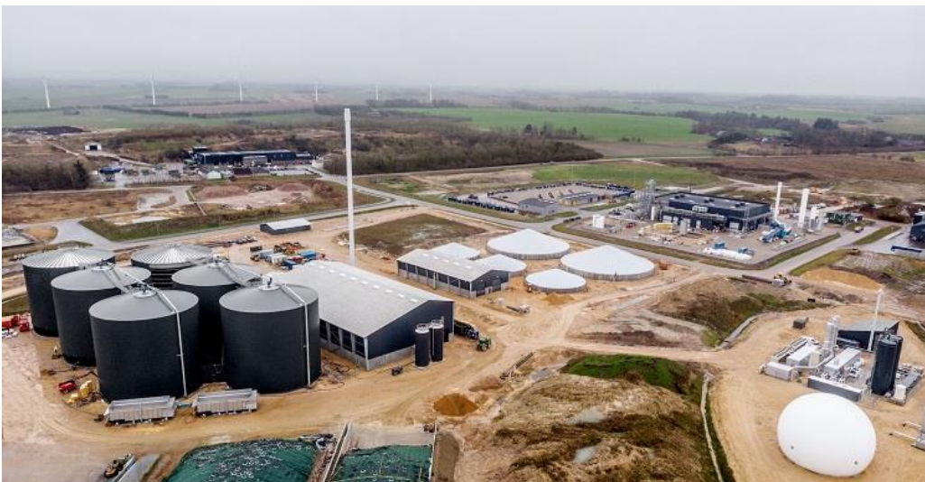
Figur 6: GreenLabs PtX-anlæg i Skive skal producere hydrogen og methanol ud fra vindmøllestrøm. Det er opført i samarbejde med energiparkens partnere Green Hydrogen System, ReIntegrate, Everfuel og Euro Wind. Foto: GreenLab Skive.
