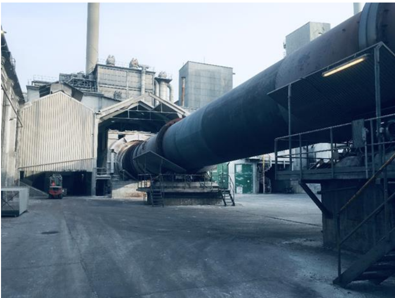
Billede 2: En del af en roterovn. Privatfoto fra besøg hos Aalborg Portland.
