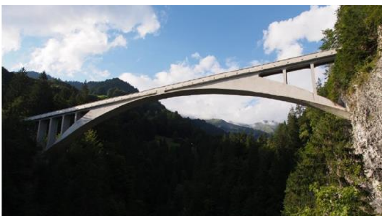
Salginatobelbrücke i Schweiz. Billede fra betonhåndbogen, kapitel 1.3
