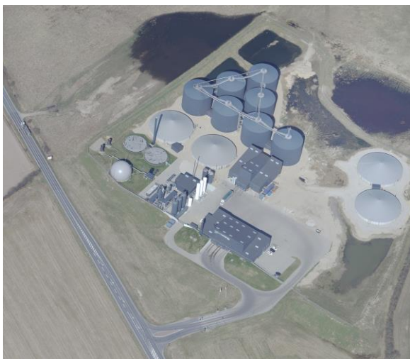
Figur 16: Eksempel på skråfoto af det store biogasanlæg ved Korskroen udenfor Esbjerg. Der er adgang til skråfoto i kortviseren fra figuren ovenfor, så I har mulighed for at have et tilsvarende billede af det anlæg, som I skal besøge. Fra SDFI-kort.
