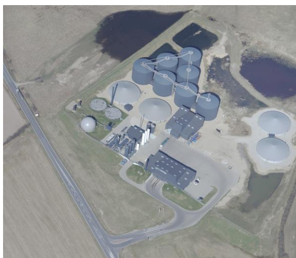
Figur 15: Eksempel på skråfoto af det store biogasanlæg ved Korskroen udenfor Esbjerg. Der er adgang til skråfoto i kortviseren fra figuren ovenfor, så I har mulighed for at have et tilsvarende billede af det anlæg, som I skal besøge. Fra SDFI-kort.
