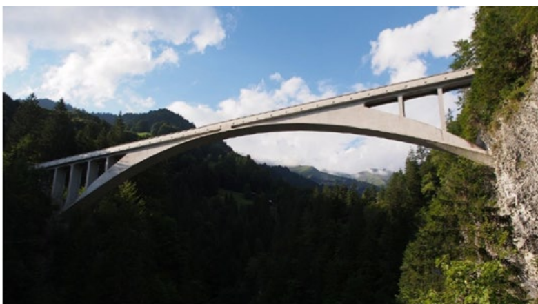
Salginatobelbrücke i Schweiz. Billede fra betonhåndbogen, kapitel 1.3
