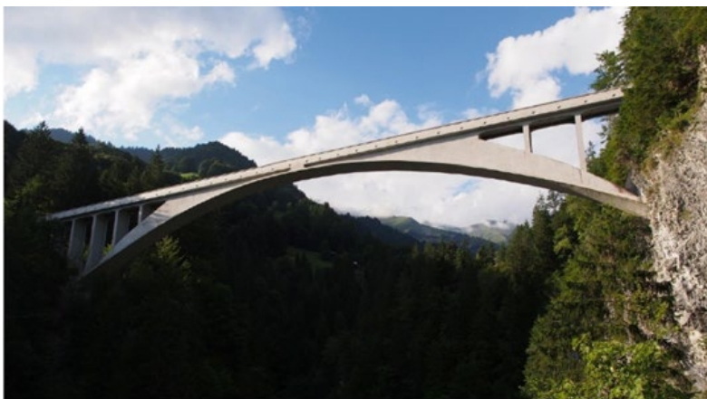
Salginatobelbrücke i Schweiz. Billede fra betonhåndbogen, kapitel 1.3
