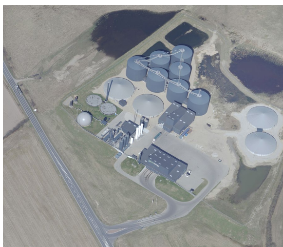
Figur 15: Eksempel på skråfoto af det store biogasanlæg ved Korskroen udenfor Esbjerg. Der er adgang til skråfoto i kortviseren fra figuren ovenfor, så I har mulighed for at have et tilsvarende billede af det anlæg, som I skal besøge. Fra SDFI-kort.
