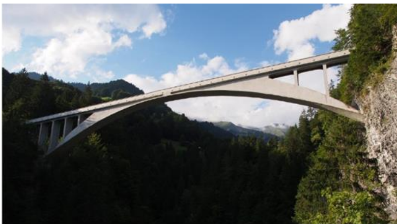
Salginatobelbrücke i Schweiz. Billede fra betonhåndbogen, kapitel 1.3
